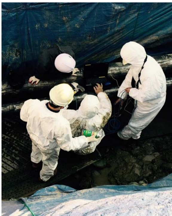
第2図 埋設配管検査現場
