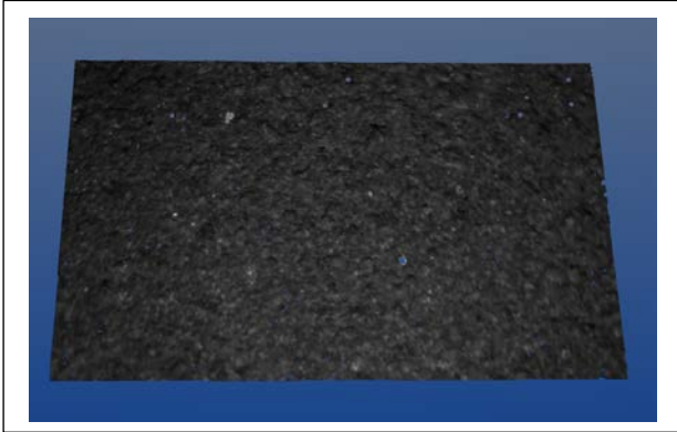
図5 光3次元計測装置で計測した耐候性鋼材のレベル3の表面腐食の3次元データ
