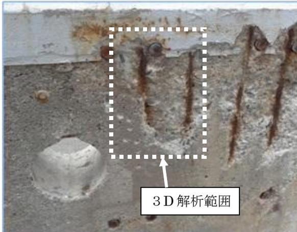
Fig. 6 道路橋のコンクリート基礎部の損傷（上）
