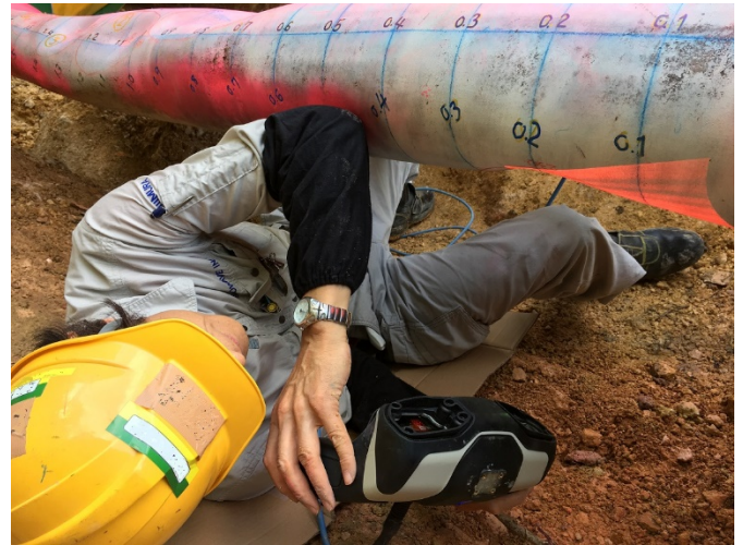
写真3. 配管底部の計測
